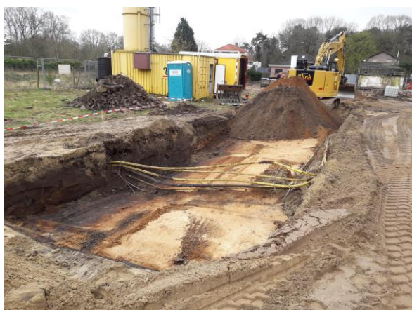
Foto 13: Ontgraving verontreiniging onder klinkerpad d.d. 6 april 2022.
