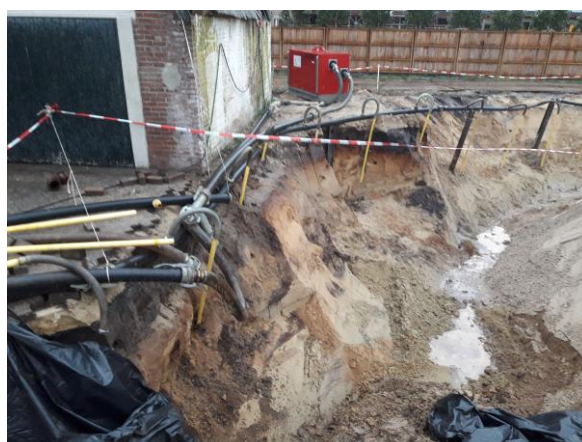
Foto 14: Ontgraving ter plaatse van gevel woning 344, d.d.7 april 2022
