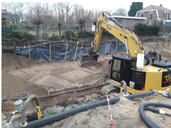
Foto 11: Overzicht aanvulling. Op de achtergrond is de foliewand zichtbaar, ter hoogte van perceel 1451
