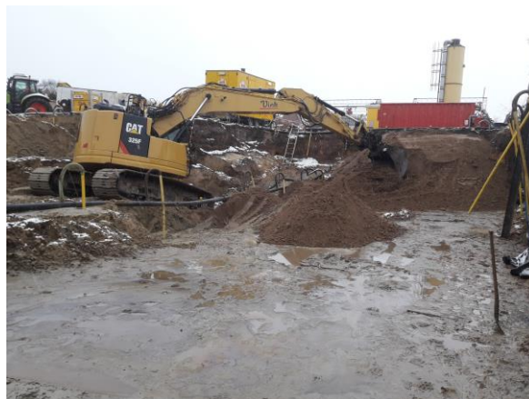
Foto 10: Aanvulling ontgraving met schoon zand (depot D).
