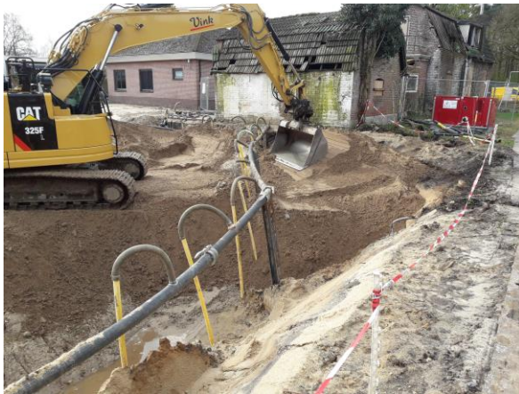
Foto 15: Aanvulling ontgraving nabij woning 344 d.d. 8 april 2022
