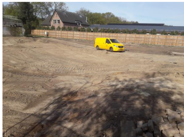
Foto 18: Eindsituatie na ontgraving.
