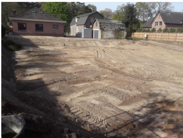
Foto 17: Eindsituatie na aanvulling ontgraving
