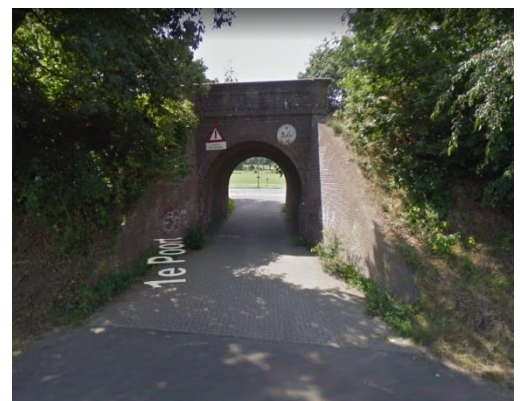
Figuur 7 Fietstunnel onder spoordijk (Bron: Google Maps)
