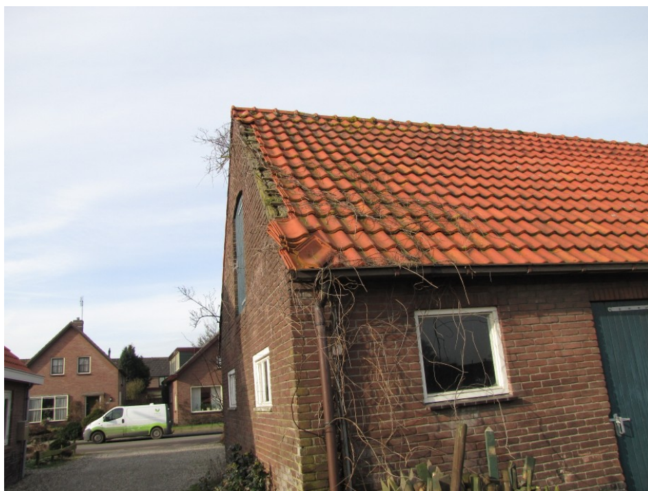
Figuur 3. Schuur met dakpannen en dubbelsteens muur zonder spouw.
