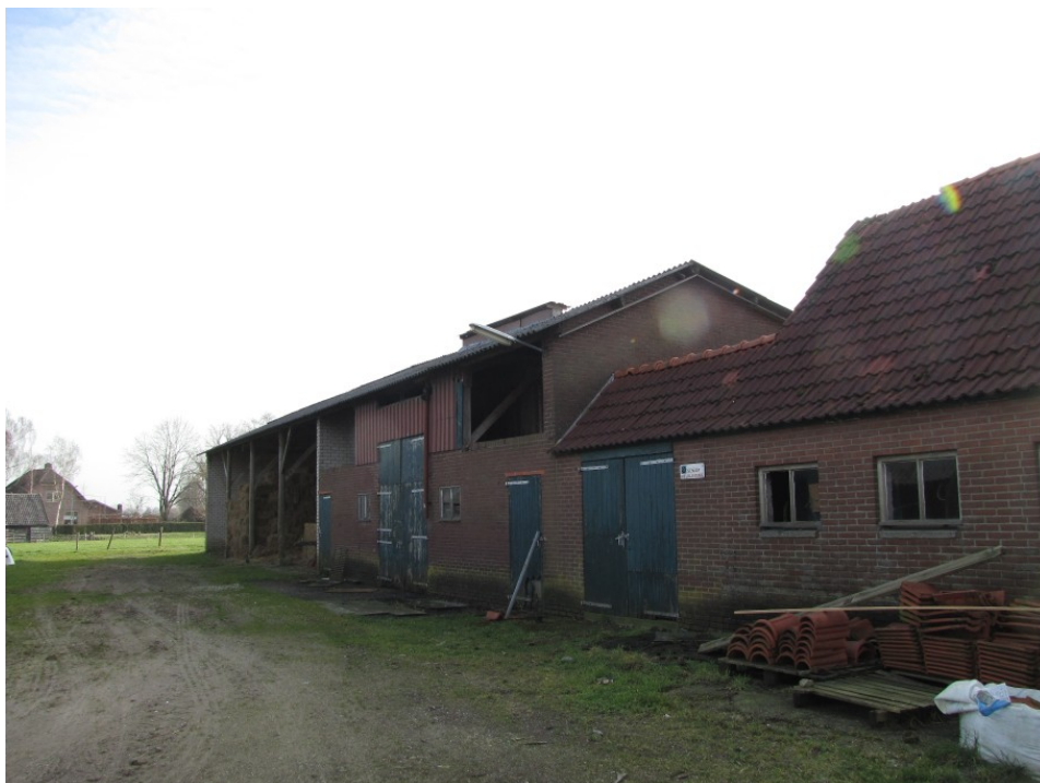
Figuur 5. Stenen stal/halfopen kapschuur met spouwmuur en dak met dakpannen.
