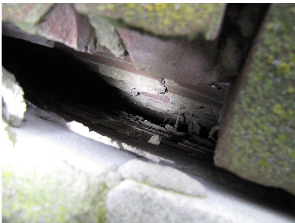
Figuur 6. Voor vleermuizen geschikte ruimte tussen twee steenlagen.
