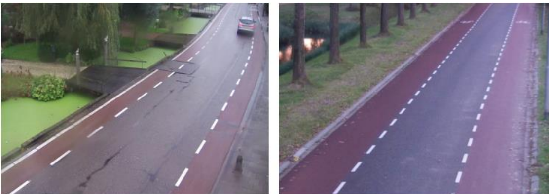
Figuur 4.7: Links: Smalle fiets(suggestie)stroken en middenrijloper met onduidelijke breedte. Rechts: fietsstroken met voldoende breedte voor twee fietsers en een middenrijloper voor één personenauto (bron: CROW-Fietsberaad – Aanbevelingen fiets- en kantstroken)
