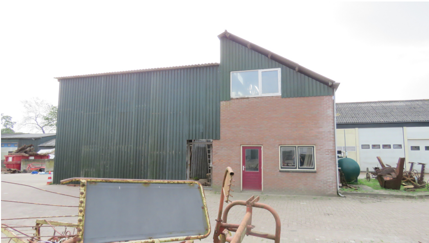
Afbeelding 5: Zicht op de opstallen vanaf de noordzijde.
