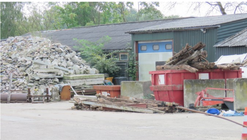
Afbeelding 4: Zicht op de opstallen vanaf de noordzijde.
