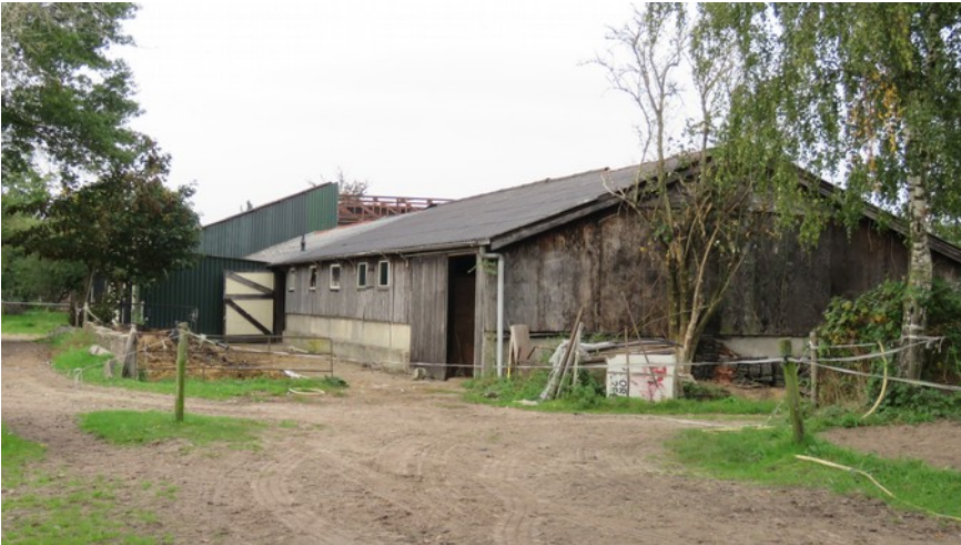
Afbeelding 2: Zicht op de opstallen op het terrein, in de voorste schuur worden paarden gestald.
