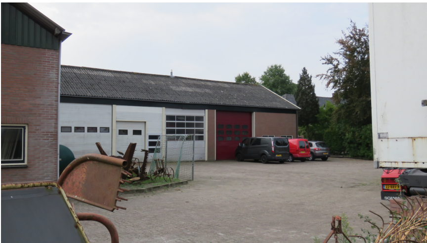
Afbeelding 6: Zicht op de opstallen vanaf de noordzijde.
