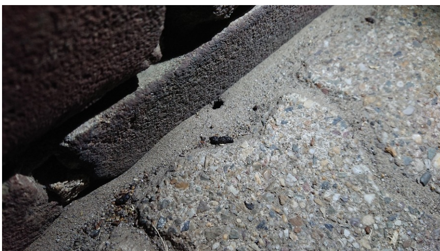
Afbeelding 10: Ketel van een dwergvleermuis langs de gevel
