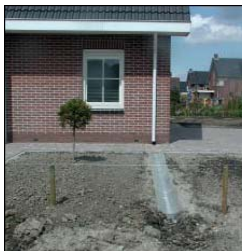
Figuur 12: gootje om hemelwater af te voeren
