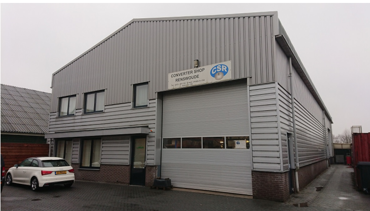
Afbeelding 4: De onderzochte loods aan de Barneveldsestraat
