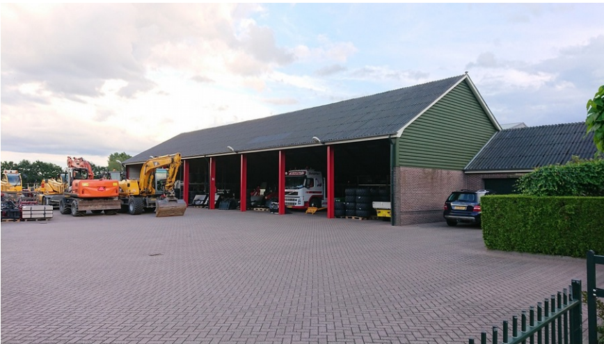
Afbeelding 3: Half-open loods in het plangebied.
