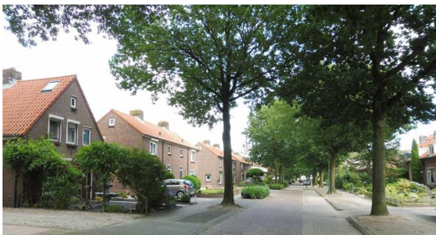
Taets van Amerongenweg, links op de foto de te slopen woningen
