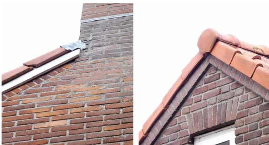
Kieren bij dakrand met potentie voor verblijfplaatsen van gebouwbewonende vlermuizen
