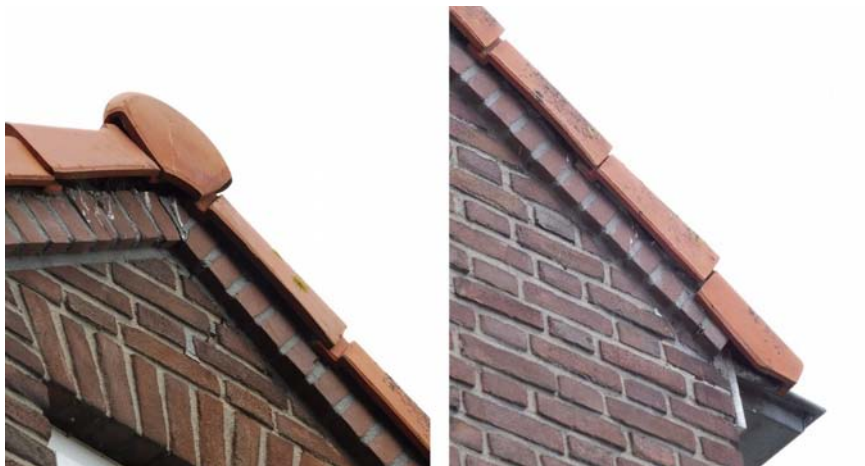
Geschikte openingen voor huismus of gierzwaluw onder dakrand. Poepsoren zijn aanwezig.
