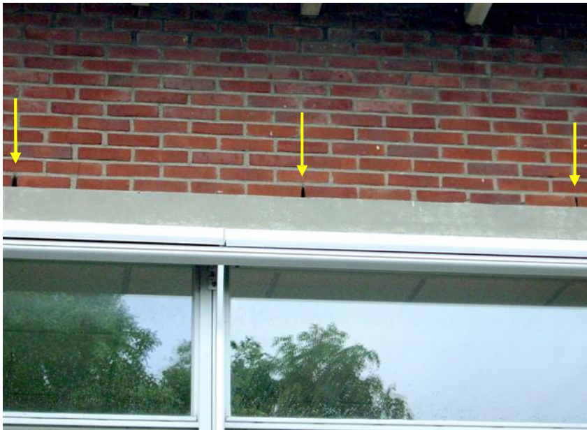
Figuur 6: Gaten in de westgevel van het nieuwere gebouw.
