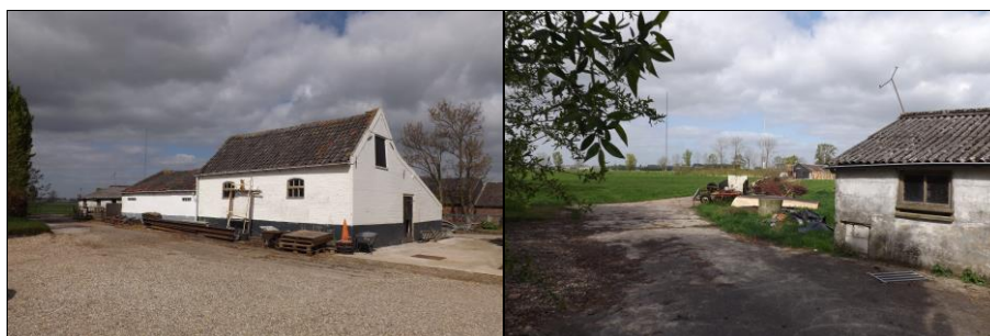
Te slopen bebouwing en achterliggende grasland Lopikerweg oost 170
