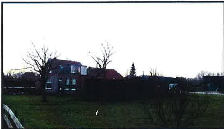
Voorgevel vanaf de Batuwseweg
