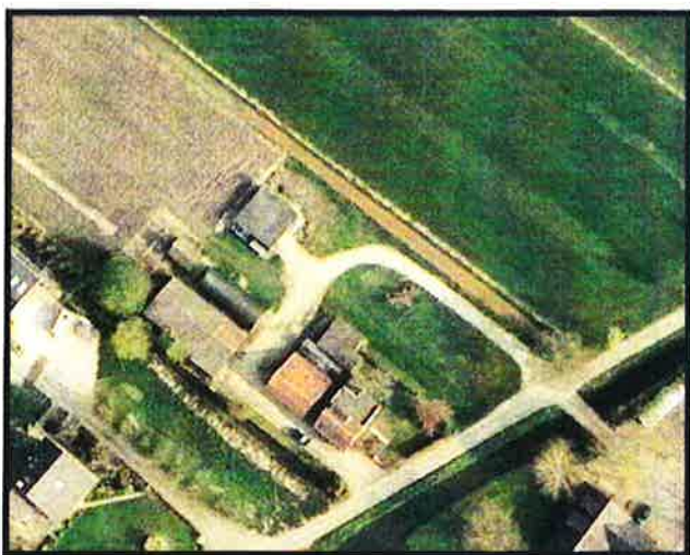
Luchtfoto bestaande situatie
