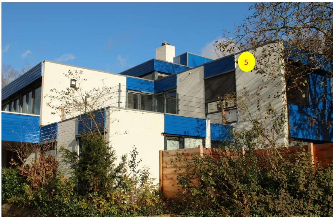
Foto 3. Locatie van paarkast 5 aan een westgevel.
