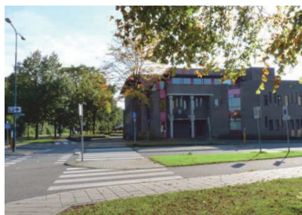
Fig. 4. Gemeentehuis, gezien vanaf de parkeerplaats aan Het Erf.
