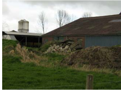
Foto 5: Enkele hopen puin achter schuur.
