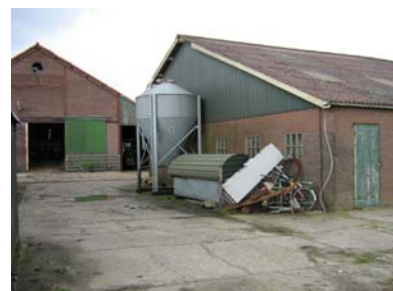
Foto 3: Schuur met asbestverdachte golfplaten en bovengrondse tank in lekbak met overkapping.
