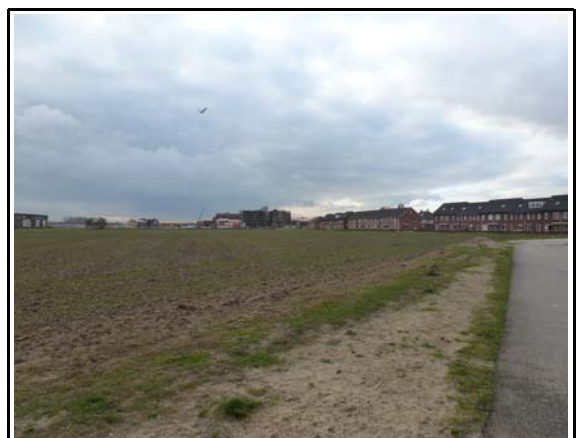
Foto 12: locatie gezien vanaf oostelijk deel
