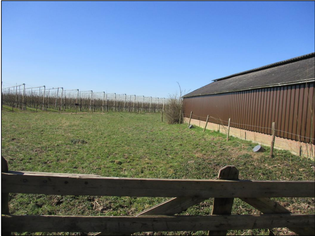
Figuur 3 De te slopen loods grenst aan een grasweide.
