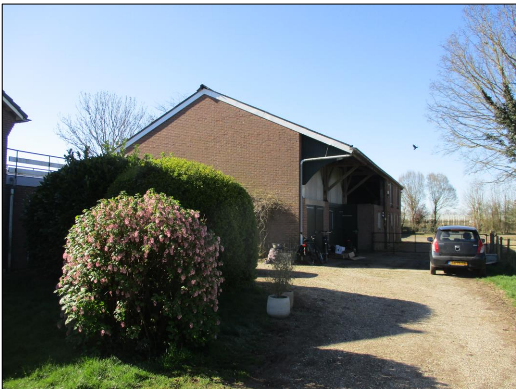
Figuur 2 De schuur die verbonden staat met de woning blijft behouden in de beoogde ontwikkeling en krijgt een woonbestemming.
