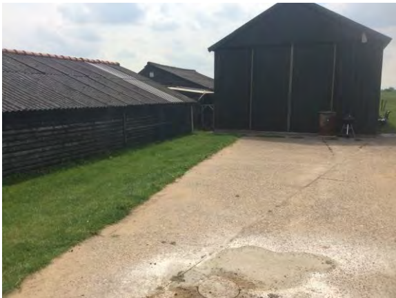
Figuur 7: Overzichtsfoto bebouwing
