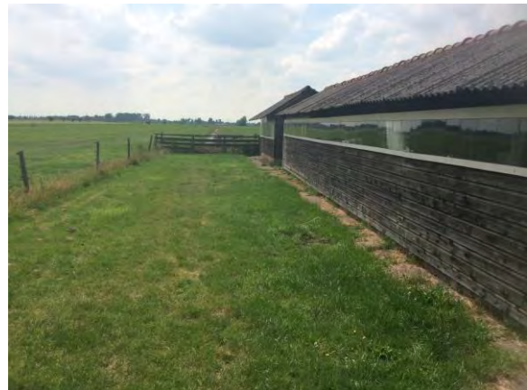
Figuur 8: Overzichtsfoto bebouwing
