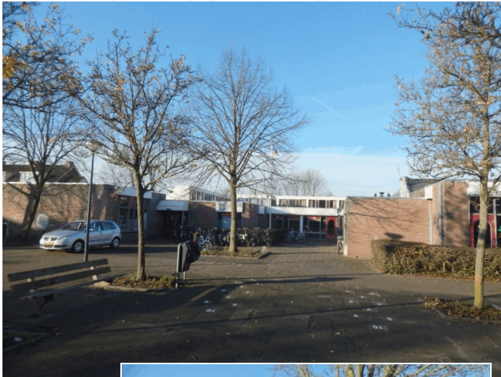
Deel van het plangebied: de ingang van de voormalige school (foto naar west)
