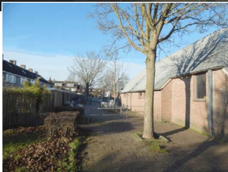
De gymzaal aan de zuidzijde (foto naar het westen genomen)
