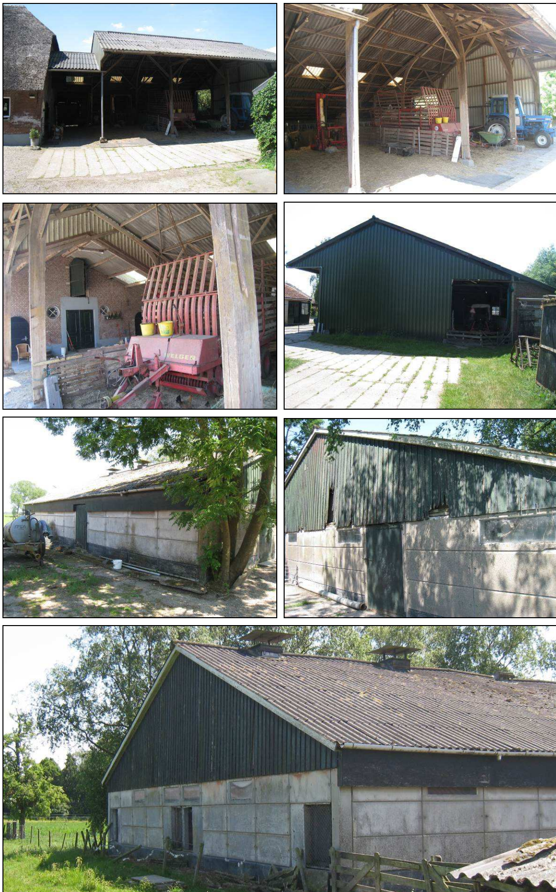
Figuur 2. Aanzicht van de te verbouwen schuur (bovenste vier foto's) en de te slopen schuur (onder).
