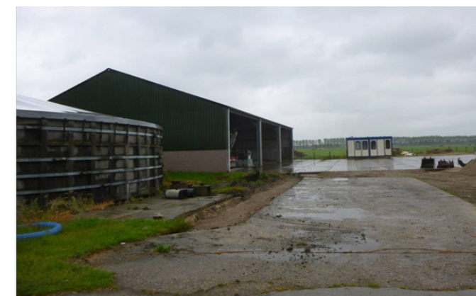
te slopen agrarische bebouwing op perceel Kaaidijk 13
