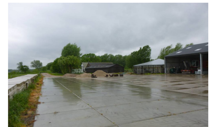
te slopen agrarische bebouwing op perceel Kaaidijk 13
