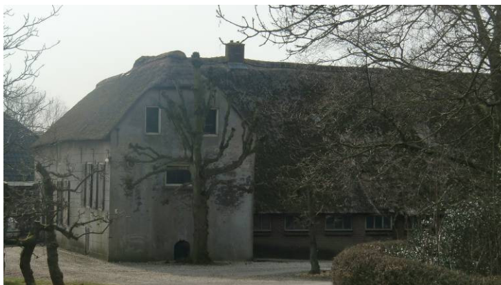
Afbeelding 18: Lagedijk 32 Boerderijvorm: T-huis: hierbij zijn er aan beide zijden van het woongedeelte uitbouwen gemaakt, waardoor het geheel een de vorm van een omgekeerde T heeft gekregen.
