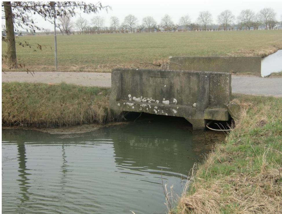
Afbeelding 37 - Betonnen bruggetje uit 1939 - aan de vooravond van de Tweede Wereldoorlog werden nog snel allerlei verbeteringen aan de Nieuwe Hollandse Waterlinie aangebracht. Het mocht niet baten: vliegtuigen maakten vaste verdedigingslinies vrijwel nutteloos.
