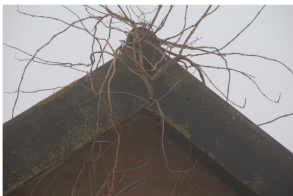
Nok van de schuur.
