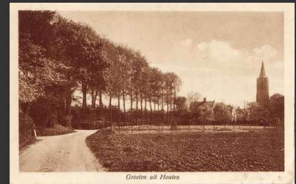
Ansichtkaart met gezicht over de Burgemeester Wallerweg, rond 1910. Houten is nog een verdichte nederzetting in het open landschap
