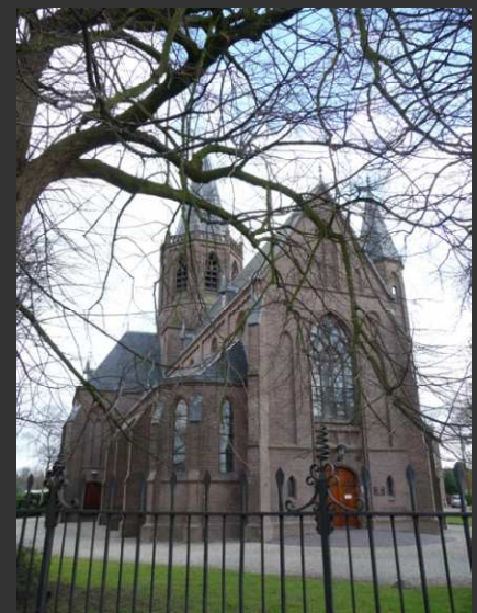
Complex van Rooms-katholieke kerk is Rijksmonument
