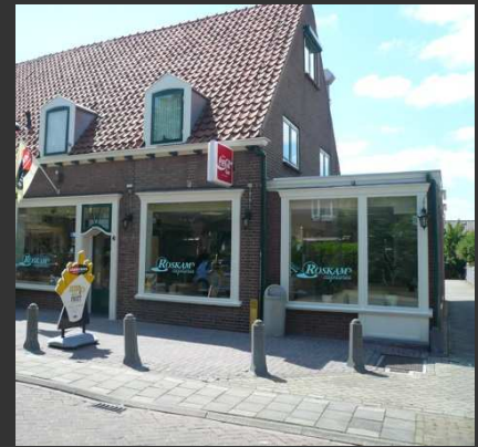
Door gebruik van functionele deeloplossingen ontbreekt in de openbare ruimte een samenhangende bestrating
