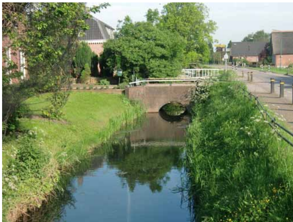
Afbeelding 8 - De Waalse Wetering ter hoogte van het plangebied - deze middeleeuwse gegraven waterloop ontwikkelde zich met de naastgelegen weg, tot de ontwikkelingsas van de boerderijen van Tull en 't Waal.
