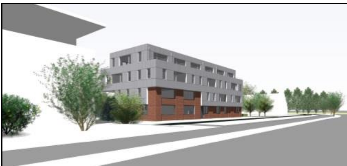
Gevel gezien vanaf de Amersfoortseweg
