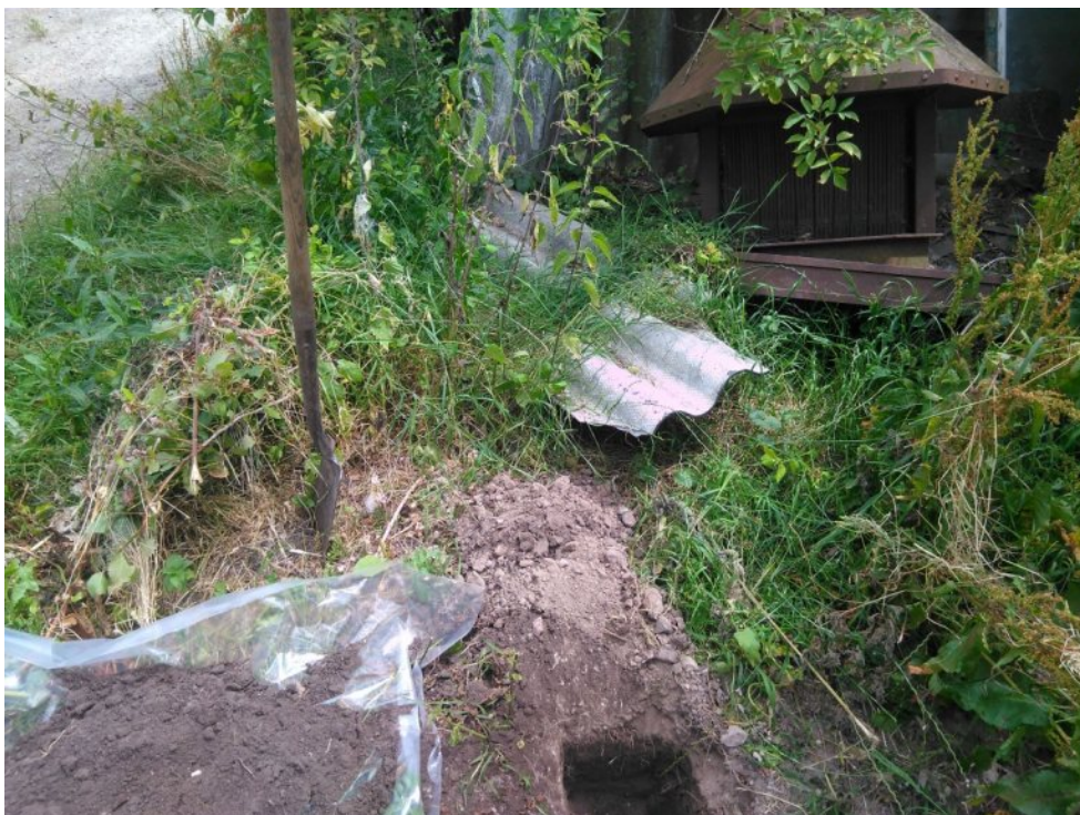
Foto 7: asbestverdacht materiaal op het maaiveld (zie asbestinventarisatie)
