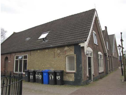
Afb. 163 Dorpsstraat 77. De gele bakstenen zijn bouwsporen die dateren uit de zeventiende eeuw (164? vermeld op muur).
