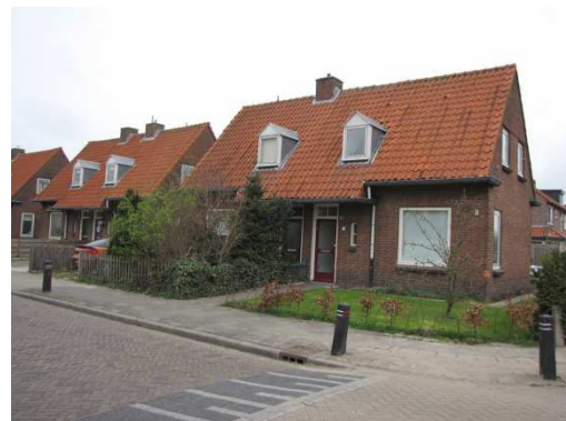
Afb. 147 Nijkerkerweg. Het dak is boven de entree naar beneden toe doorgetrokken.
