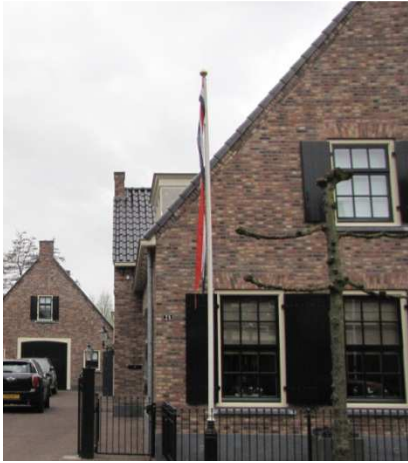
Afb. 169 Dorpsstraat 28. Een nieuw volume dat is opgetrokken met gemeleerde bakstenen, waardoor een onrustig aanzicht ontstaat.
