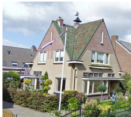
Afb. 166 Molenstraat 35. Grote delen van de gevel zijn in gele baksteen opgetrokken.
