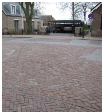
Afb. 42 Aanduiding in de bestrating van de onder het maaiveld aangetroffen funderingen van de zuidelijke stadspoort.
