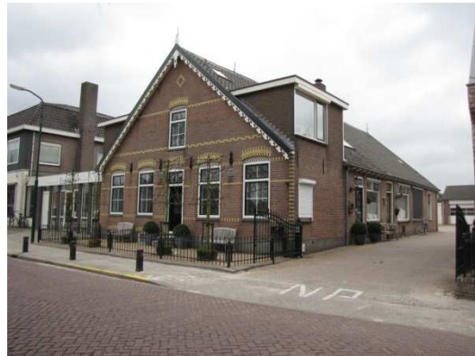
Afb. 108 Koningin Wilhelminastraat 60: grote bakstenen kapellen en vensters in de zijgevel.
