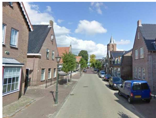
Afb. 118 Straatbeeld Dorpsstraat. De gevels liggen pal aan de stoep of hebben een ondiepe voortuin. De gevels liggen wel in elkaars verlengde. Oorspronkelijk zal de stoep ook hier tot aan de gevel hebben gelopen.
