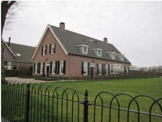
Afb. 119 Dorpsstraat 146. Deze nieuwe boerderij is op een aanzienlijke afstand van de straat gebouwd, waardoor wordt afgeweken van de karakteristiek van boerderijen die pal aan de straat grenzen.
