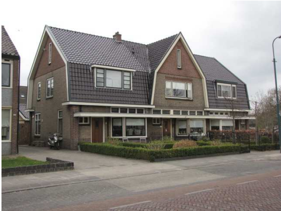
Afb. 145 Molenstraat 37-39. Bouwvolume waarbij de steekkap het blok onderverdeelt.
