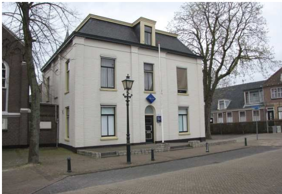
Afb. 168 Kolkplein 1 is wit gesausd, waardoor het grafisch spel van baksteen en voeg (metselverband) niet meer beleefbaar is.
