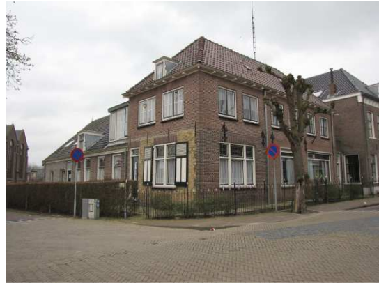
Afb. 164 Dorpsstraat 1-3. De gele bakstenen zijn bouwsporen die dateren uit de zeventiende eeuw.
