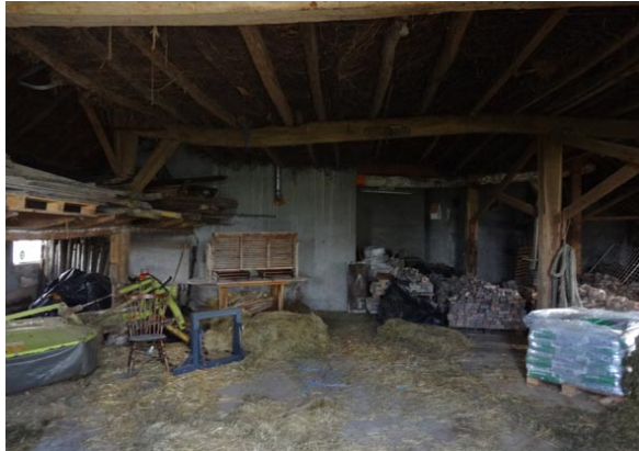
Binnenaanzicht stallen dwarshuisboerderij, toekomstig zorgappartementen.
