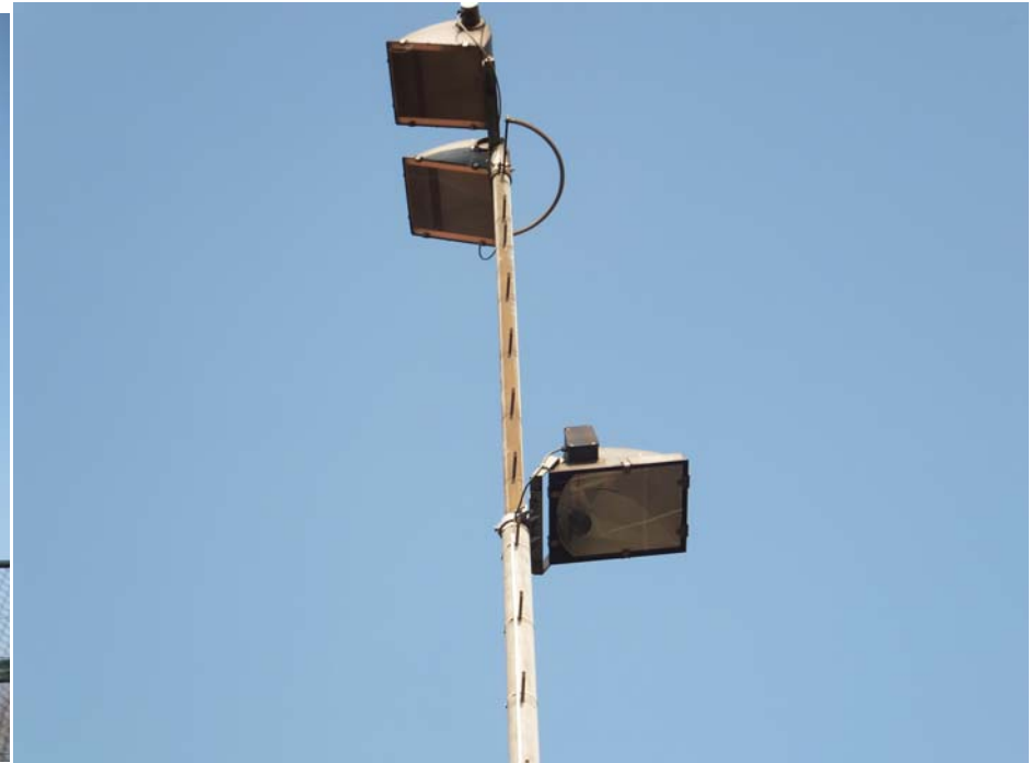
Foto 8 Plaats lampen langs tennisbaan hoogte 14,5 m, onderste lamp op 10 m
