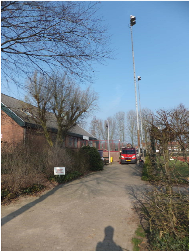
Foto 1 Plaats lampen langs tennisbaan hoogte 14,5 m
