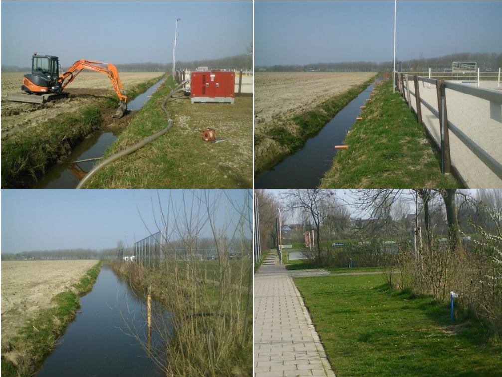
Figuur B3.2 Overzicht uitvoering infiltratieproef
