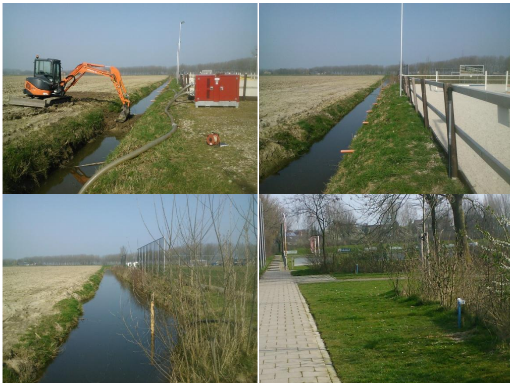
Figuur B3.2 Overzicht uitvoering infiltratieproef
