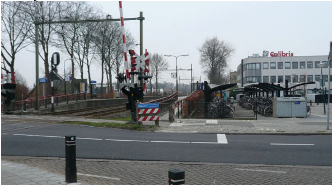
Figuur 3: Calibris gebouw en fietsenstallingen aan de noordzijde van het perron
