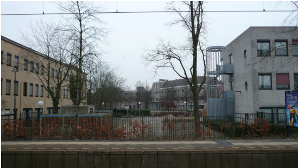
Figuur 4: Parkeerterrein Calibris en het perron
