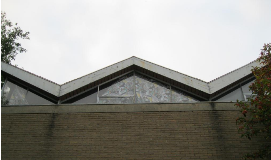
De dakrand van de kerk is zeer geschikt voor vleermuizen en gierwaluwen
