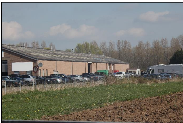
Locatie 19, open schuur autobedrijf
