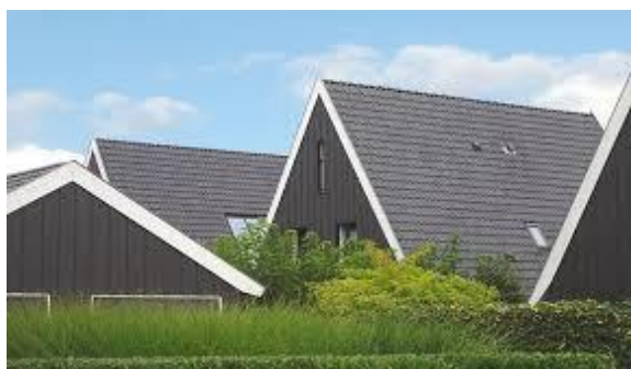
Sprekende daklijsten (Bron Buro Huijbrechtse)
