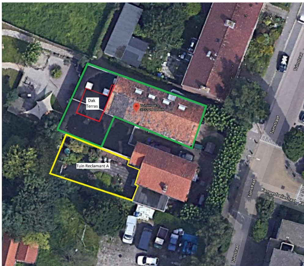
Afbeelding 1.1: Overzicht van de situatie dakterras Tuinstraat 3
