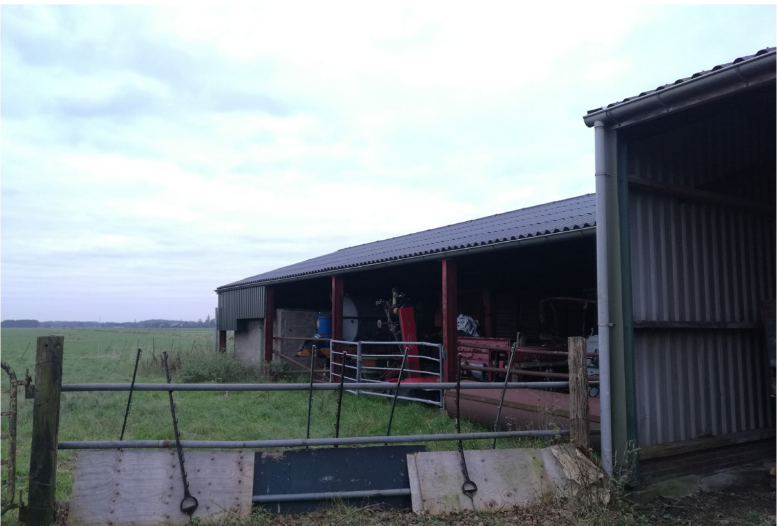
Te slopen kapschuren in het projectgebied
