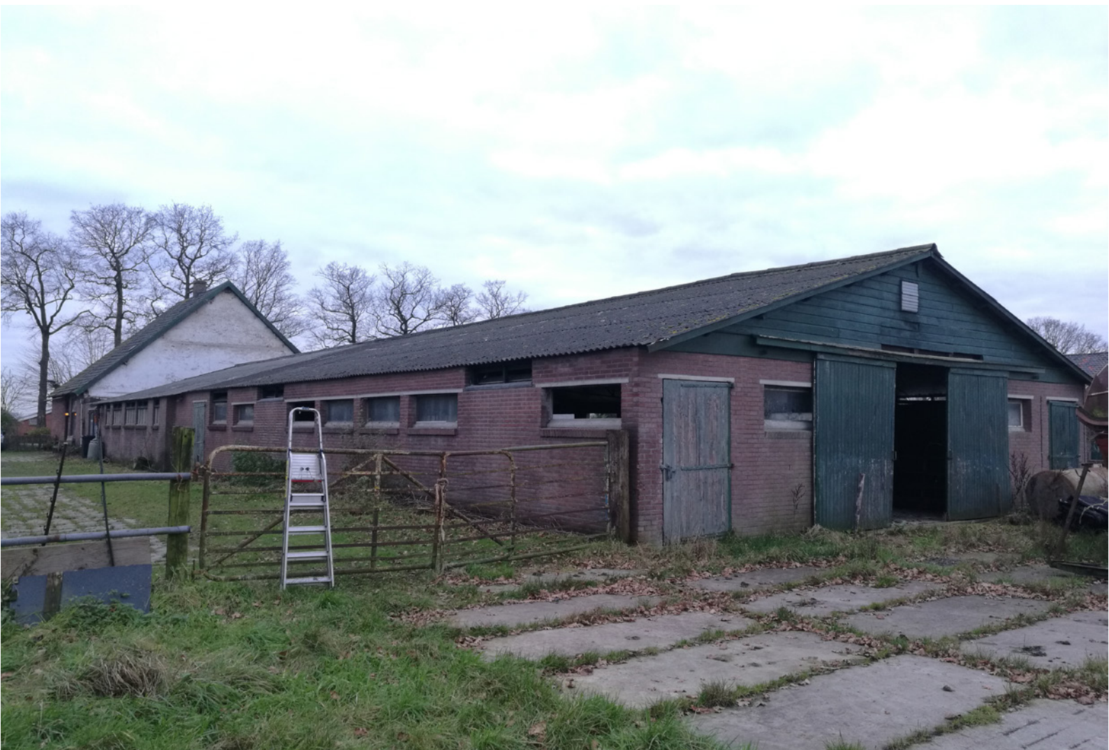
Te slopen koeienshuur met verblijfplaats kerkuil
