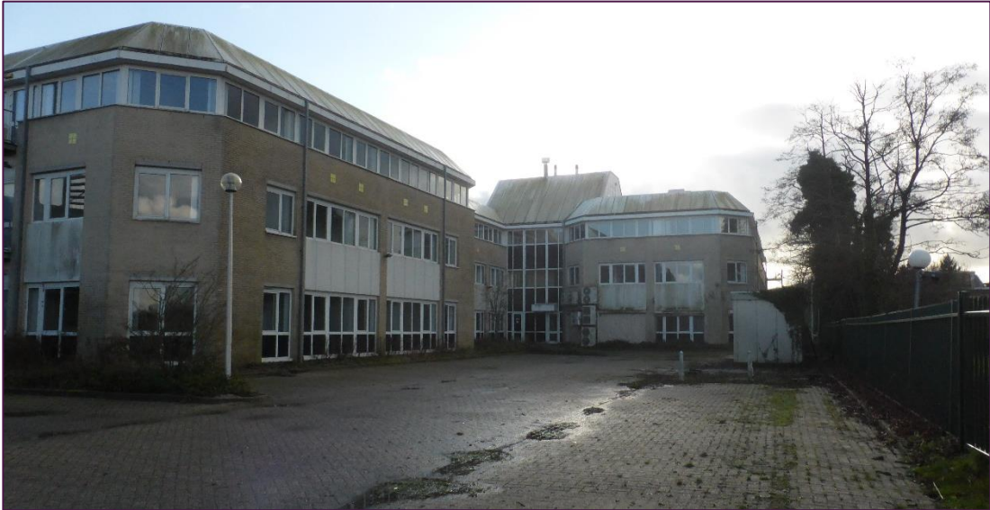
Figuur 2.2. Parkeerplaats aan achterzijde en hoofdgebouw gezien vanuit het noorden
