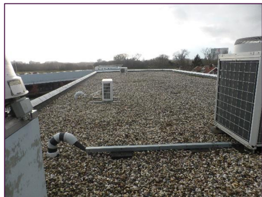
Figuur 4.10. Dak van westelijke deel van het hoofdgebouw
