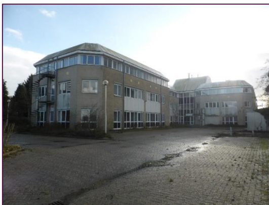
Figuur 4.1. De verharde parkeerplaats aan de noordelijke zijde van het plangebied
