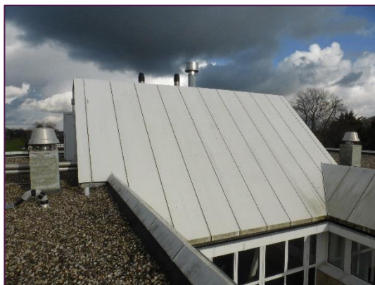
Figuur 4.9. Constructie op het dak bekleed met metalen panelen
