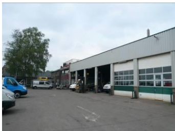
Werkplaats en entree Veldhuizen wagenbouw bv
