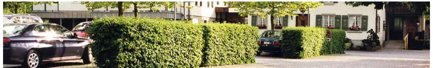
de parkeerplaatsen op het Vinkenplein voegen zich naar de groene sfeer van het brinkachtige plein
