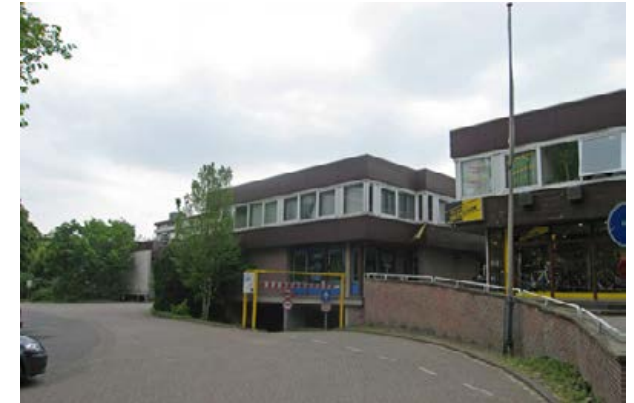
de bestaande auto-entree aan de zijde van de Spreeuwlaan
