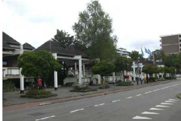
de bestaande hoofdentree aan de Sperwerlaan
