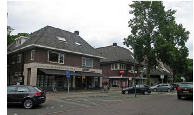
bebouwing aan de noord-oostzijde is nog herkenbaar als woonbebouwing en staat verder uiteen
