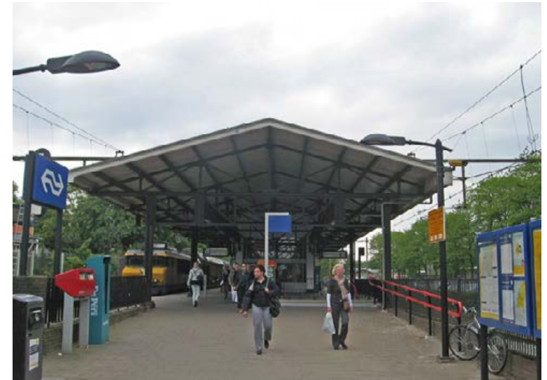
de oorsprong van Bilthoven: het station met de monumentale overkapping
