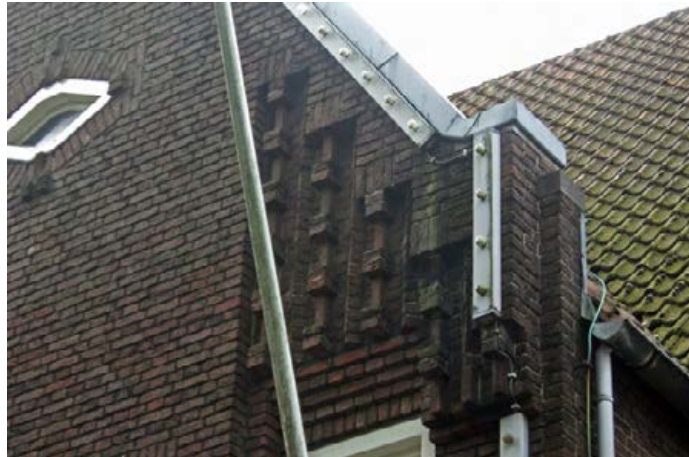
bebouwing is overwegend uitgevoerd in baksteen in aardse tinten, soms uitgevoerd met rijke detailleringen
