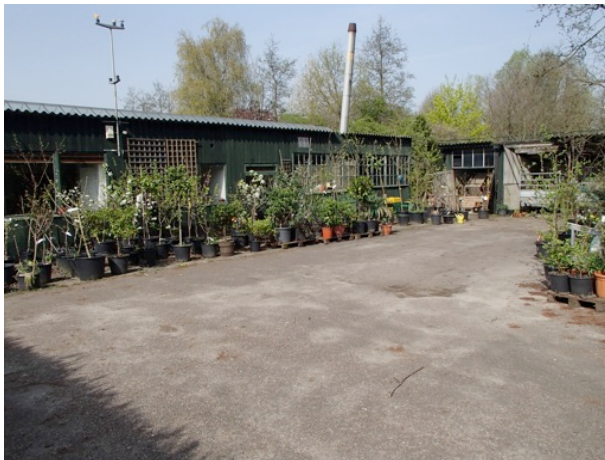
voorterrein met schuur en ketelhuis
