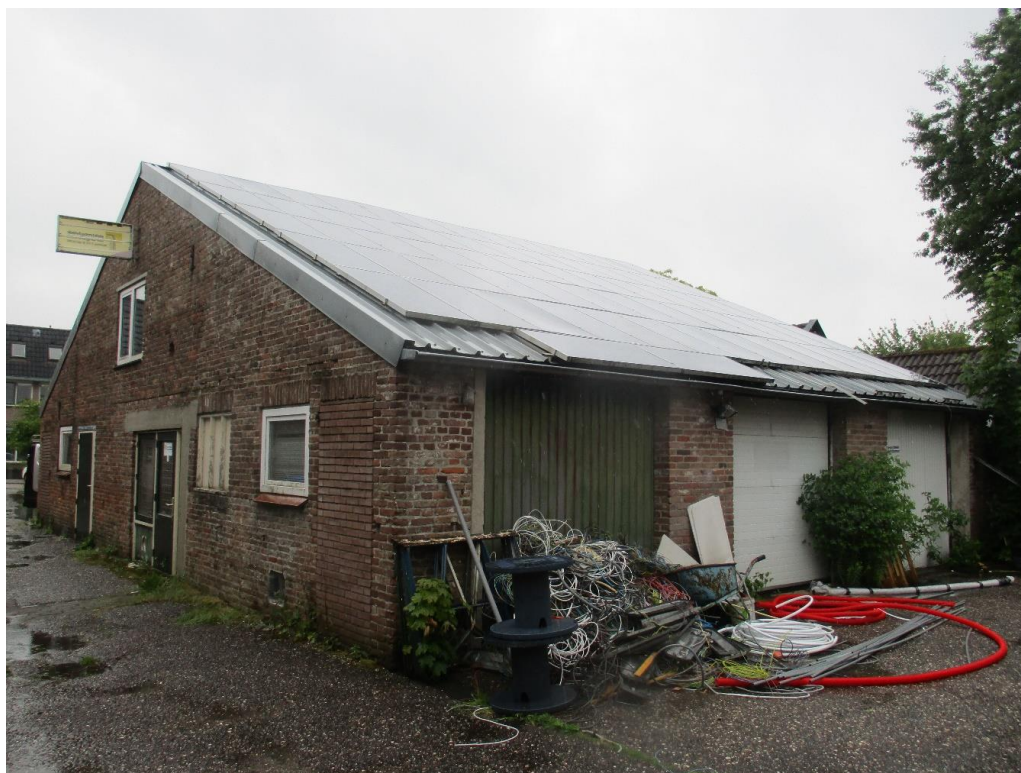
Figuur 1 Het kantoorpand aan de Zandvoortweg 27 te Baarn.
