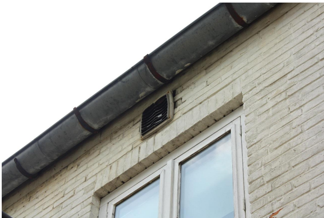
Figuur 3: opening in de muur aan de oostzijde van het pand
