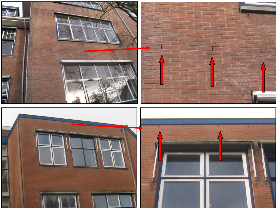
Figuur 5. Potentiele verblijfplaatsen van vleermuizen in de voormalige school aan de Smutslaan te Baarn.
