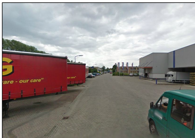
De Hermesstraat, centrale ontsluiting bedrijventerrein (bron: Google Maps)
