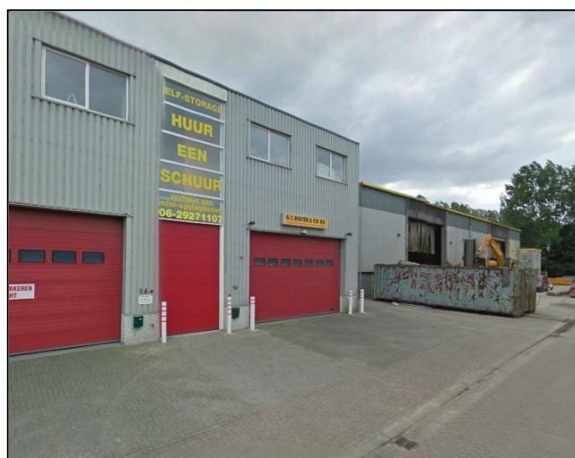
Grootschalige bebouwing op Noordschil bedrijventerrein (bron: Google maps)
