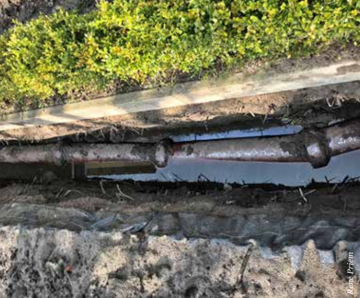
Gresbuizen bij een huisaansluiting zijn kwetsbaar voor wortelingroei
