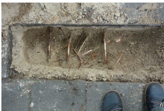
Ondoordringbaar wortelpakket aan zuidzijde boom 23218. Rechts boom 23159 met beworteling onder de trap door.
