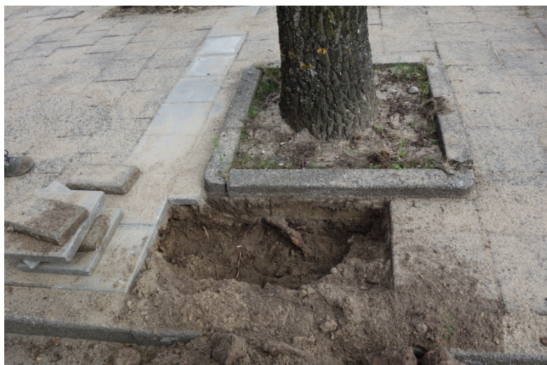
Beperkte wortelschade aan de westzijde bij boom 22519. Rechts de onderzoekslocatie. Aan de betegeling is te zien waar recent het trottoir is herstraat.
