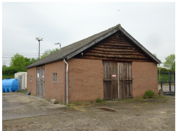
kleine loods met afgesloten zolder en mogelijke toegang via dakombouw
