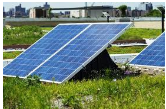
enige schaduwwerking door groen
